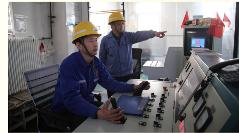
冶坪分公司青年职工在井下采掘、机电等关键岗位，深耕原煤生产、设备检修，主动参与隐患排查、应急抢修等重点工作，以实干扛起起岗位责任，用青春担当助力企业高质量发展。（付军亮）
